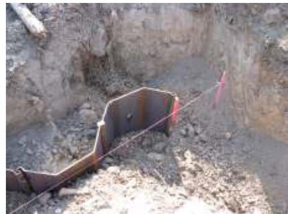
Abbildung 3: Doppelstahlbohle (eingebaut)
